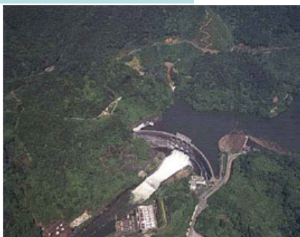
天ヶ瀬ダム S39完成 (F,W,P)
