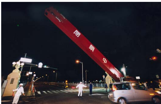
H16.8台風16号時の淀川陸閘閉鎖状況
