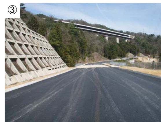
42号橋付近から上流を望む
