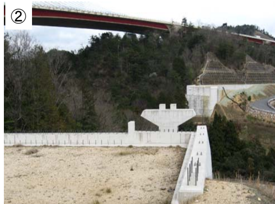
33号橋付近から上流を望む
