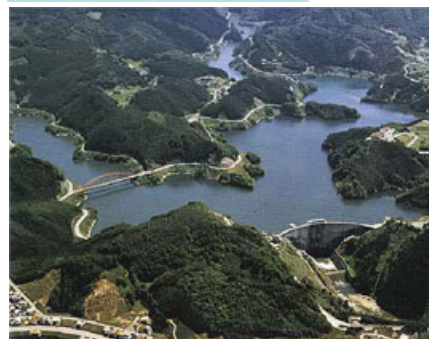
青蓮寺ダム S45完成 (F,N,A,W,P)
