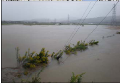
②(支川)古川橋上流部 : 田が広範囲に冠水
