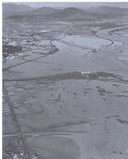
昭和47年 台風20号 亀岡市
