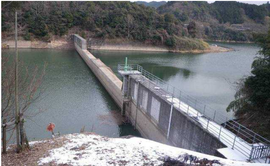
図 4.5-20 貯砂ダム（布目ダム）
