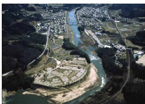
木津川上流（大臣管理区間）51～52k 付近
