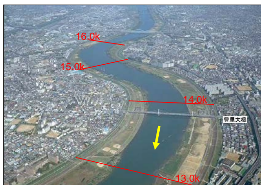
淀川（大臣管理区間）14～16k 付近
