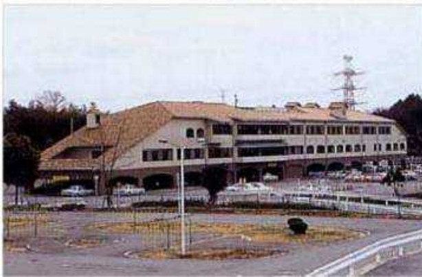
図 4.2-30 ピロティ構造の事例
