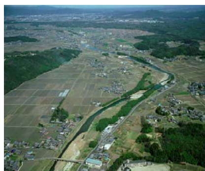
木津川（三重県管理区間）67～69k 付近
