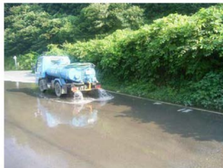
写真 3.2-1 散水の実施状況
