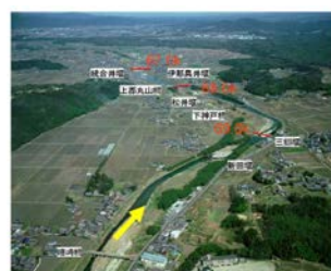
③ 木津川 (三重県管理区間) 67~69k 付近
