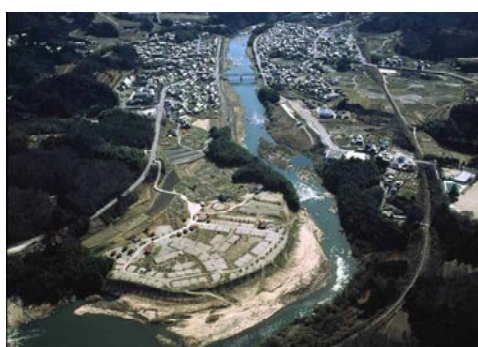
木津川上流(大臣管理区間) 51~52k 付近
