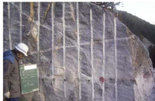
写真 3.2-9 騒音の低減(静的破碎工法)
