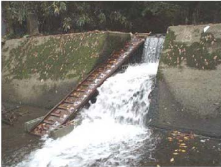
移動経路の確保状況
