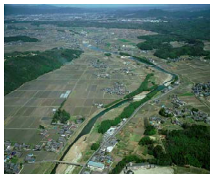
木津川（三重県管理区間）67～69k 付近
