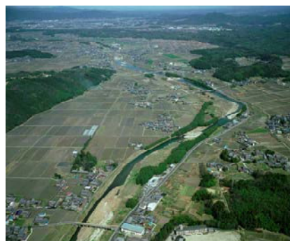
木津川（三重県管理区間）67～69k 付近
