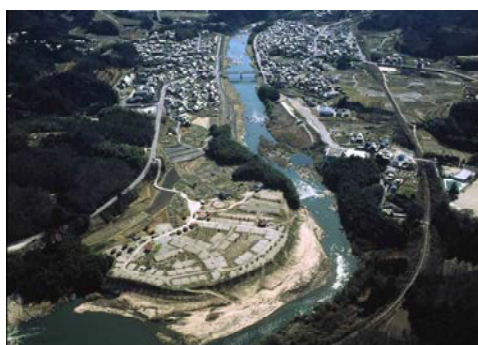
木津川上流（大臣管理区間）51～52k 付近
