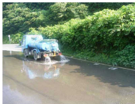
写真 3.2-1 散水の実施状況
