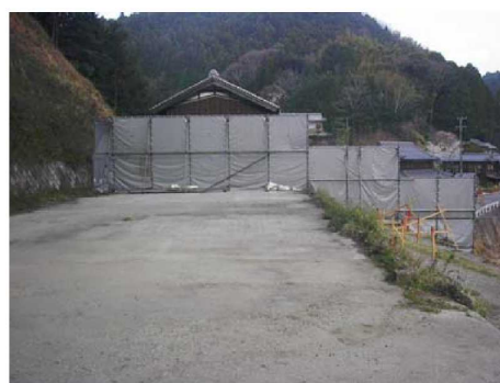
写真 3.2-2 防音壁の設置状況
