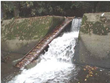
移動経路の確保状況
