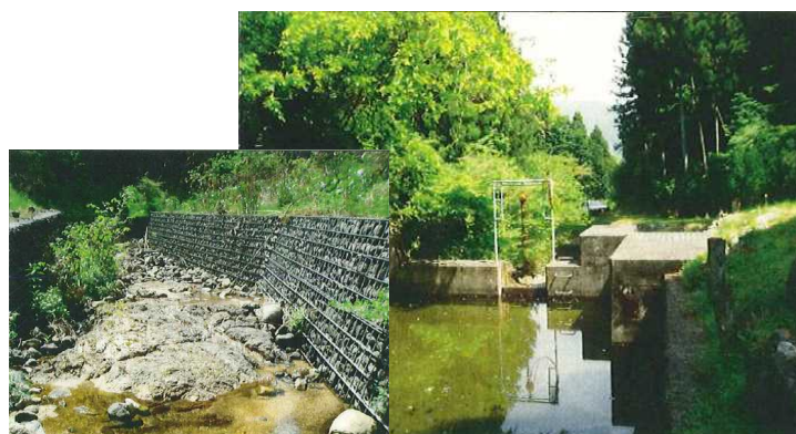
写真 2.3-1 経年的に流況が悪化し、効率が低下した水源（朝古川水系木落川）
