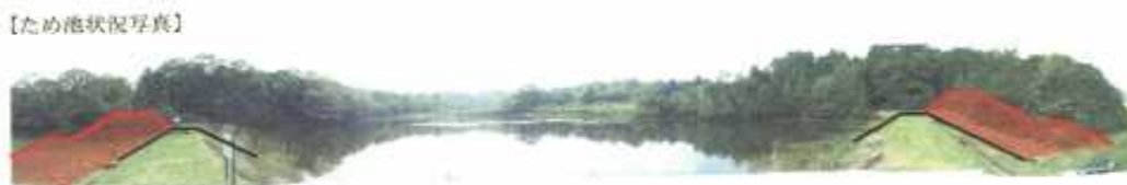
図 4.5-11 ため池かさ上げ イメージ図
