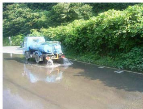
写真 3.2-1 散水の実施状況
