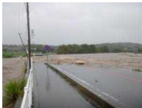
写真 2.2-8 伊賀市下神戸地区
