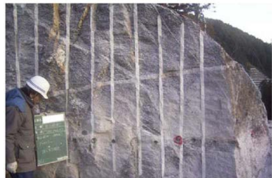
写真 3.2-9 騒音の低減(静的破碎工法)
