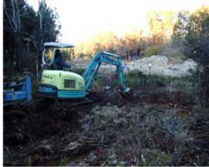
写真 3.2-11 周辺表土の採取・まき出し
