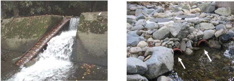
移動経路の確保状況
