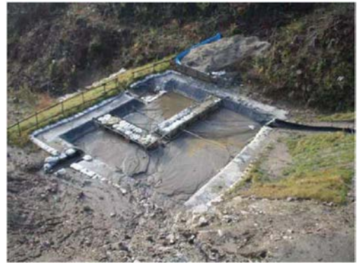
写真 3.2-4 沈砂池の設置状況
