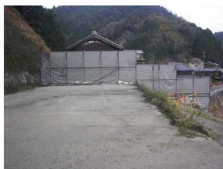
写真 3.2-2 防音壁の設置状況
