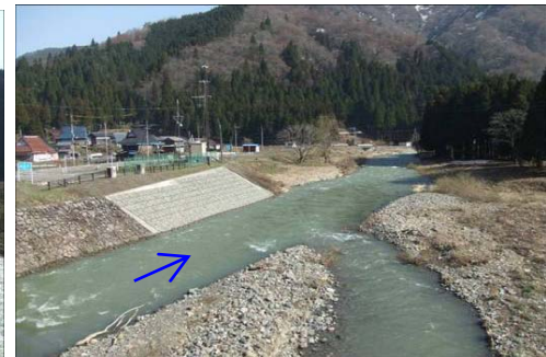
高時川上流(28.0k付近)
