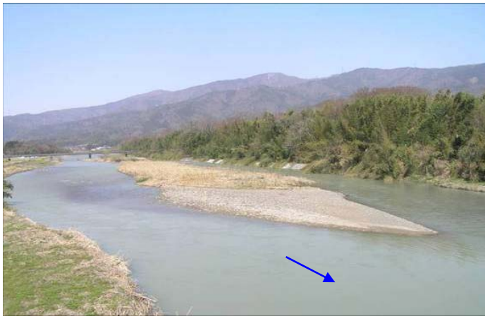
高時川12.0k付近：堤外側
