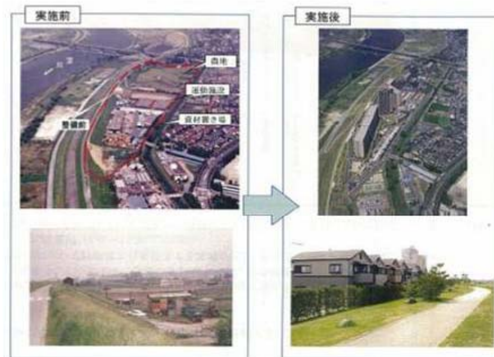
高規格堤防の実施例(淀川・伊加賀西地区)
