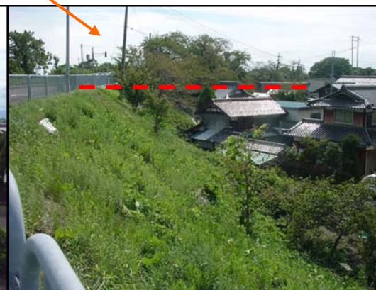
人家の2階よりも堤防が高い
