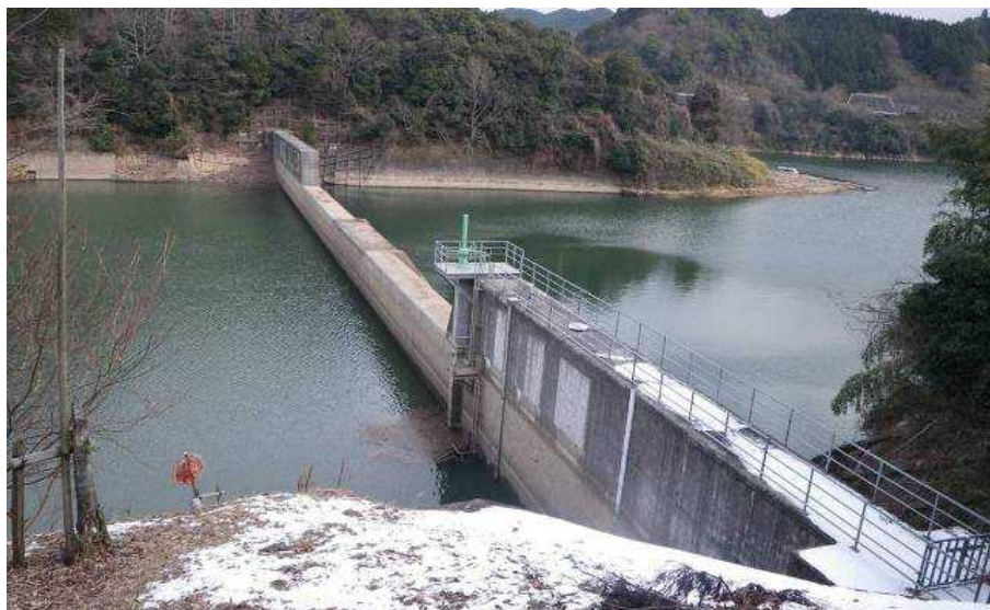
図 4.5-20 貯砂ダム（布目ダム）
