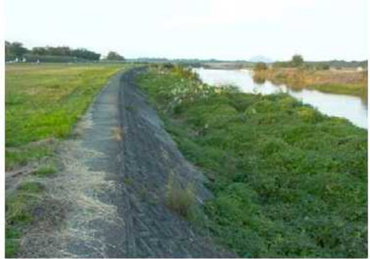
写真 2.3-5 コンクリート護岸
