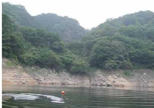
写真 2.3-6 貯水池斜面の裸地の露出状況
