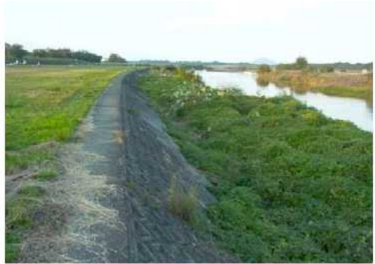
写真 2.3-5 コンクリート護岸
