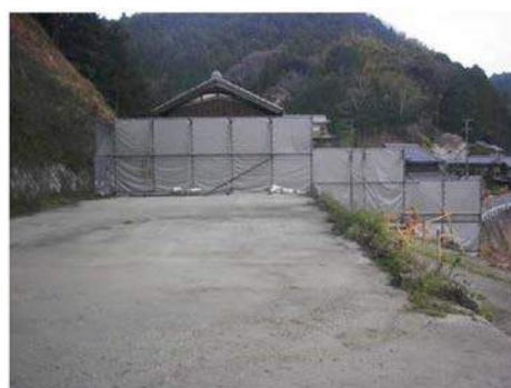
写真 3.2-2 防音壁の設置状況
