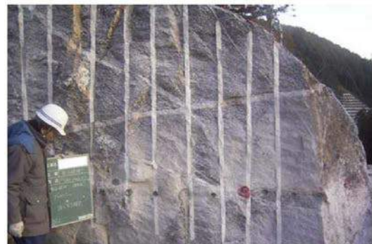
写真 3.2-9 騒音の低減(静的破碎工法)
