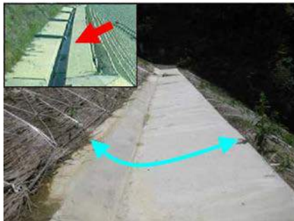
法面小段排水溝 (小写真は従来の排水溝)
