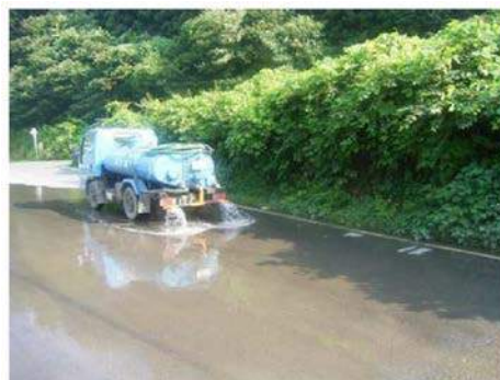
写真 3.2-1 散水の実施状況
