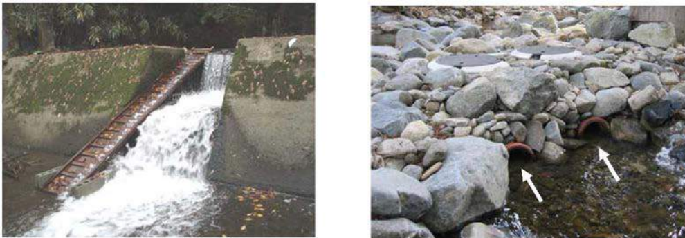
移動経路の確保状況
