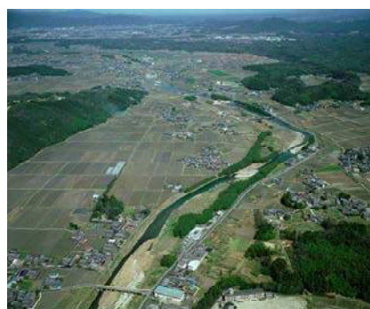
木津川(三重県管理区間) 67~69k 付近
