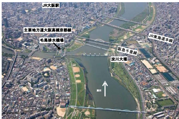
淀川と支川大川との分派点の状況(淀川左岸10.0k付近)
