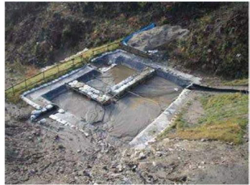
写真 3.2-4 沈砂池の設置状況
