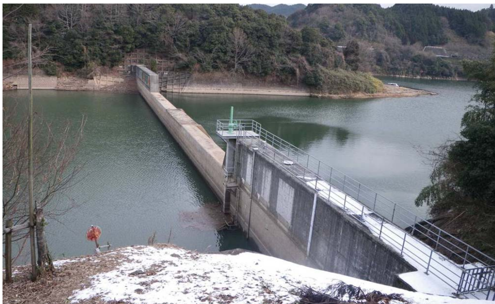
貯砂ダム（布目ダム）
