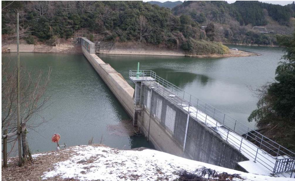
貯砂ダム (布目ダム)
