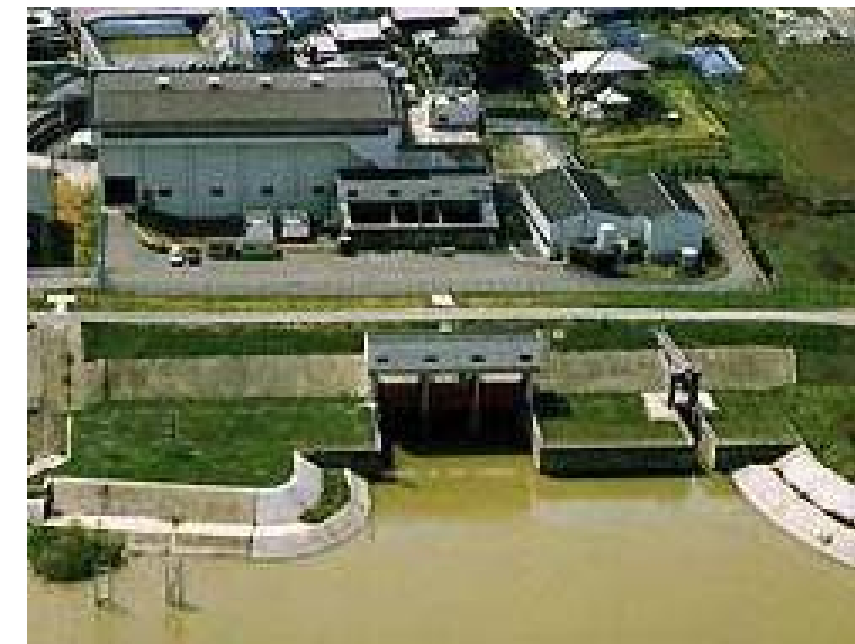
久御山川排水機場(宇治川左岸41k付近)
