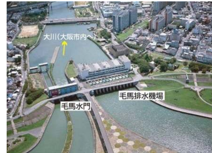
毛馬水門と排水機場(淀川左岸10k付近)
