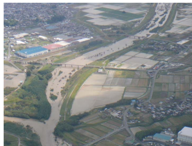
伊賀上野地区浸水状況
