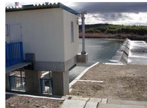
取水口から木津川を望む
