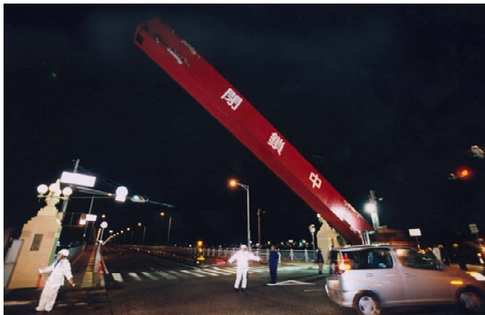
H16.8台風16号時の淀川陸閘閉鎖状況
