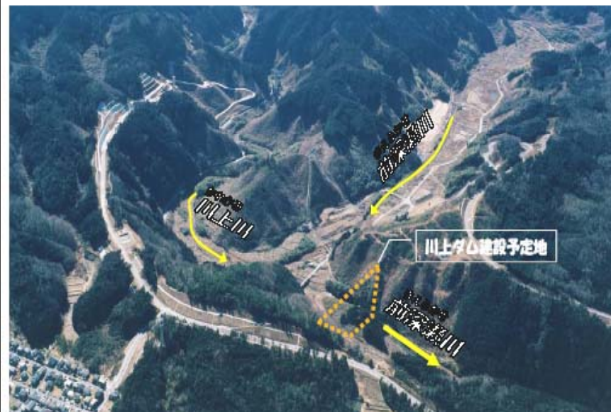
川上ダム建設予定地
