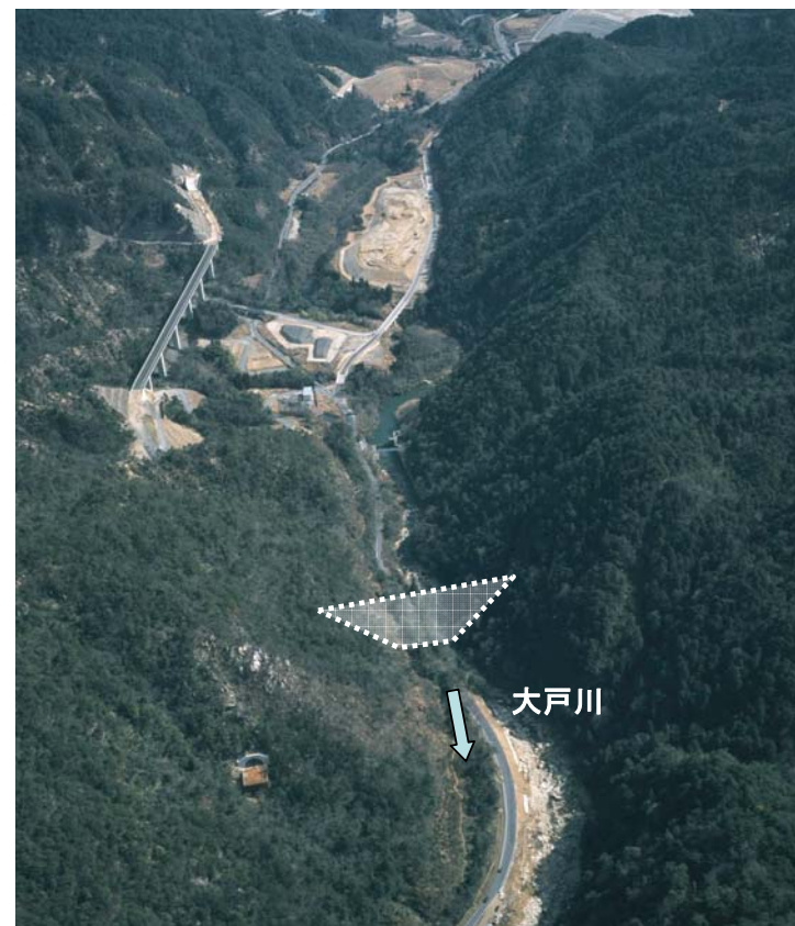
大戸川ダム建設予定地
