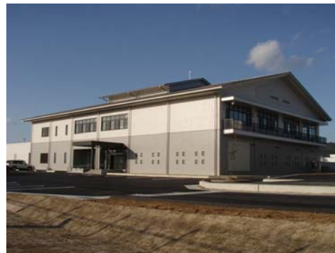
ゆめが丘浄水場管理棟
