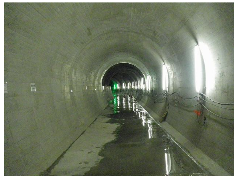
トンネル内全景
