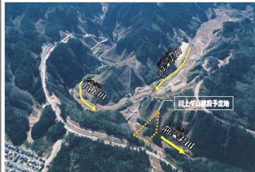
川上ダム建設予定地
