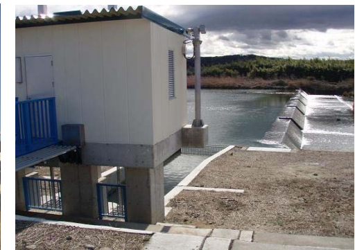
取水口から木津川を望む
