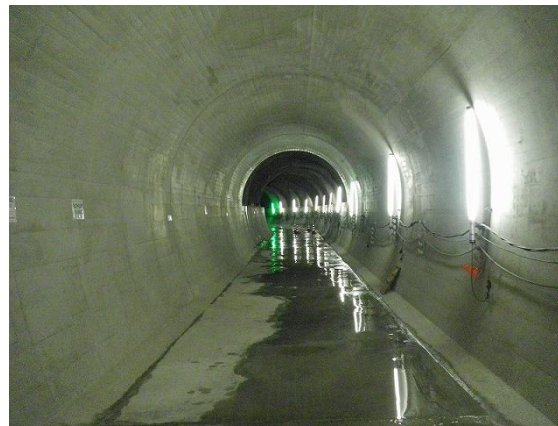
仮排水路トンネル(内部施工状況)
