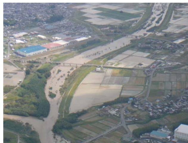
伊賀上野地区浸水状況
