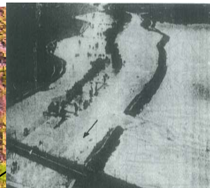
昭和34年8月洪水 野洲郡野洲町
