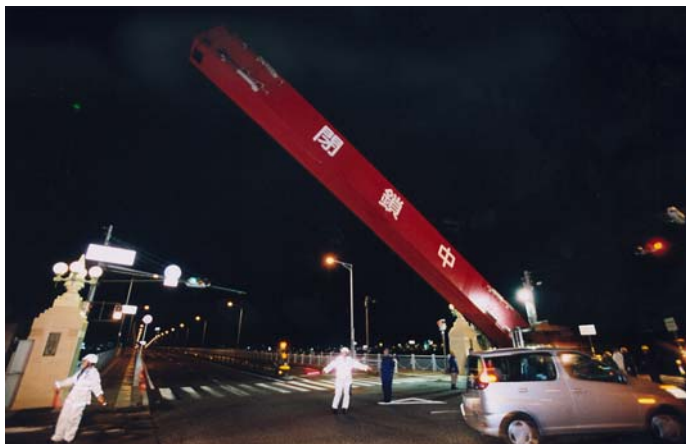
H16.8台風16号時の淀川陸閘閉鎖状況
