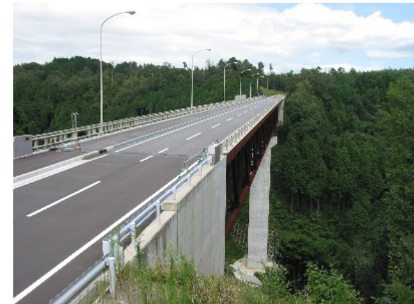
付替県道松阪青山線(要石大橋)
