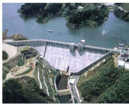
布目ダム H4完成 (F,N,W)
