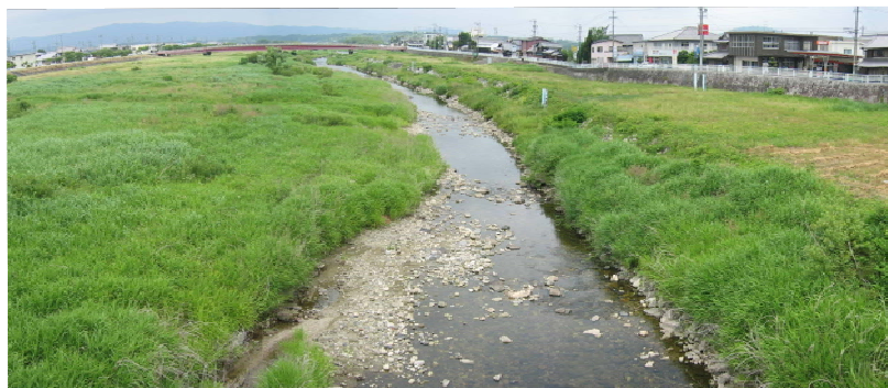
渇水時に河床が現れている状況
