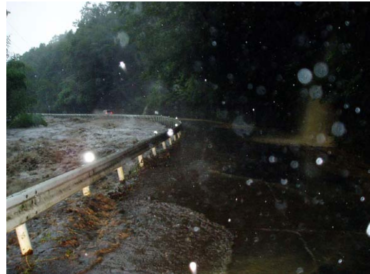
写真① ダムサイト下流 (県道水没状況)
