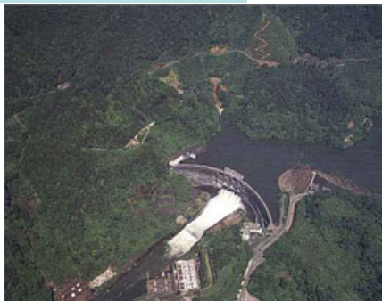
天ヶ瀬ダム S39完成 (F,W,P)
