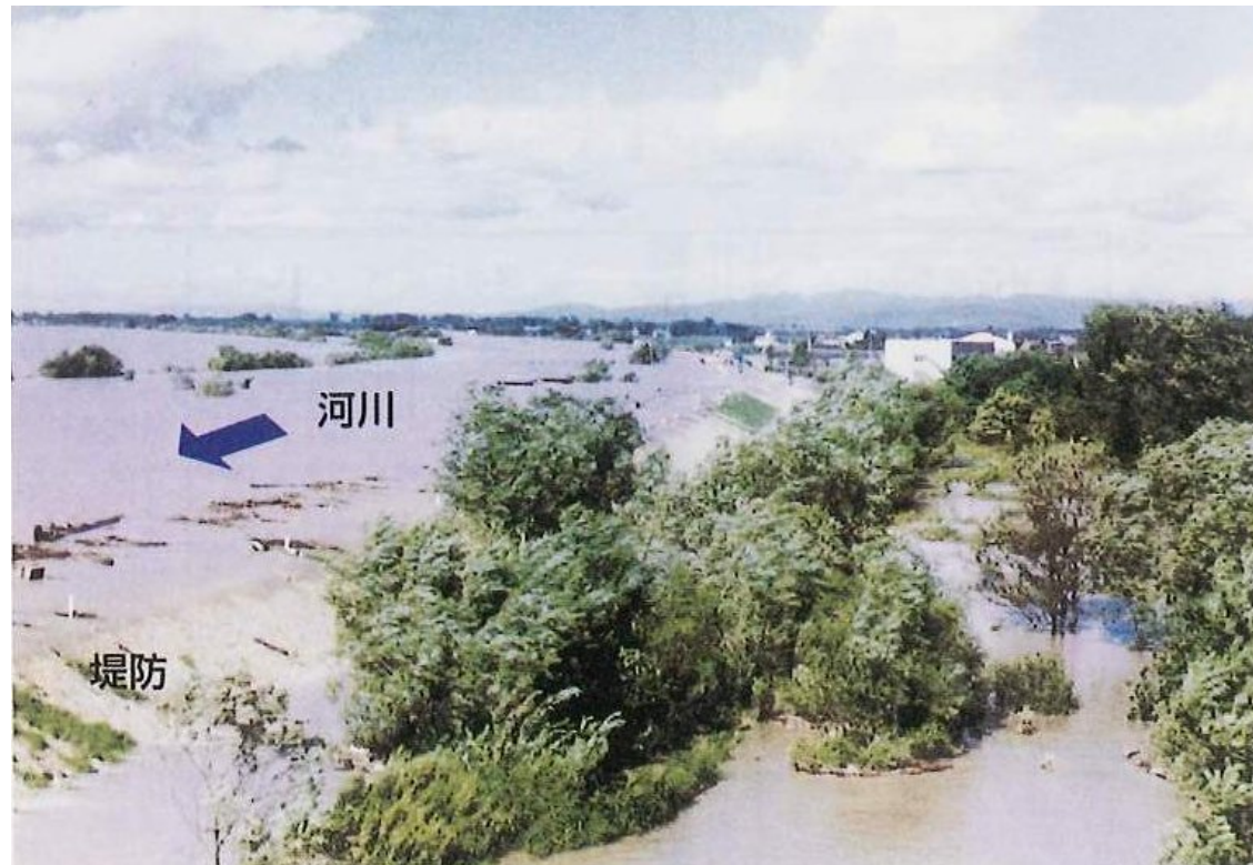
出典：堤防に沿った樹林帯の手引き
