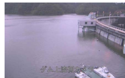
青蓮寺ダム 貯留後EL279.95m 水位上昇量約17m
