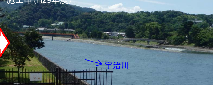
施工中(H29年度)
