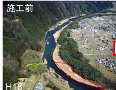
■名張川28.0k(河道掘削)
