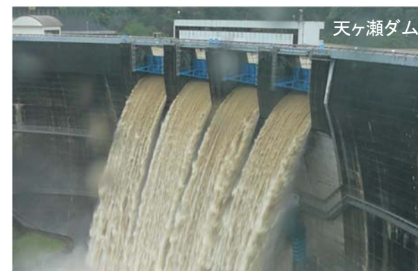
天ヶ瀬ダムの異常洪水時防災操作(H25年台風18号) 5
