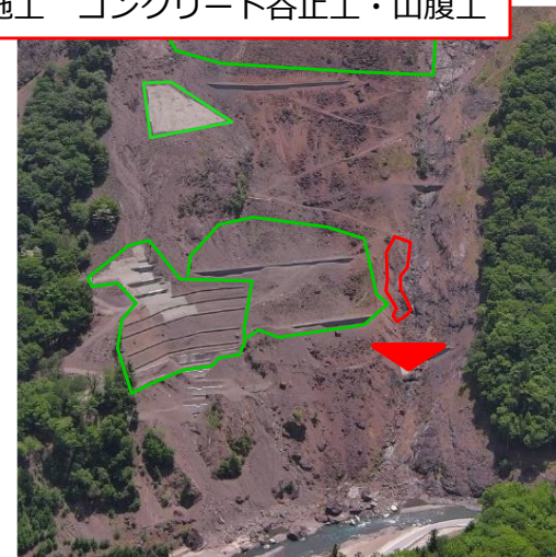
R7施工 コンクリート谷止工・山腹工
