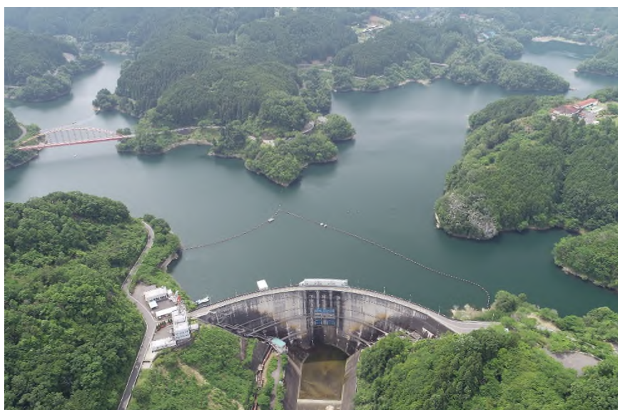
図 1.2.3-1 青蓮寺ダム全景
