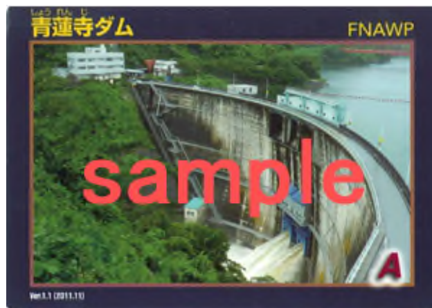
図 7.5.3-3 青蓮寺ダムのダムカード(サンプル)
