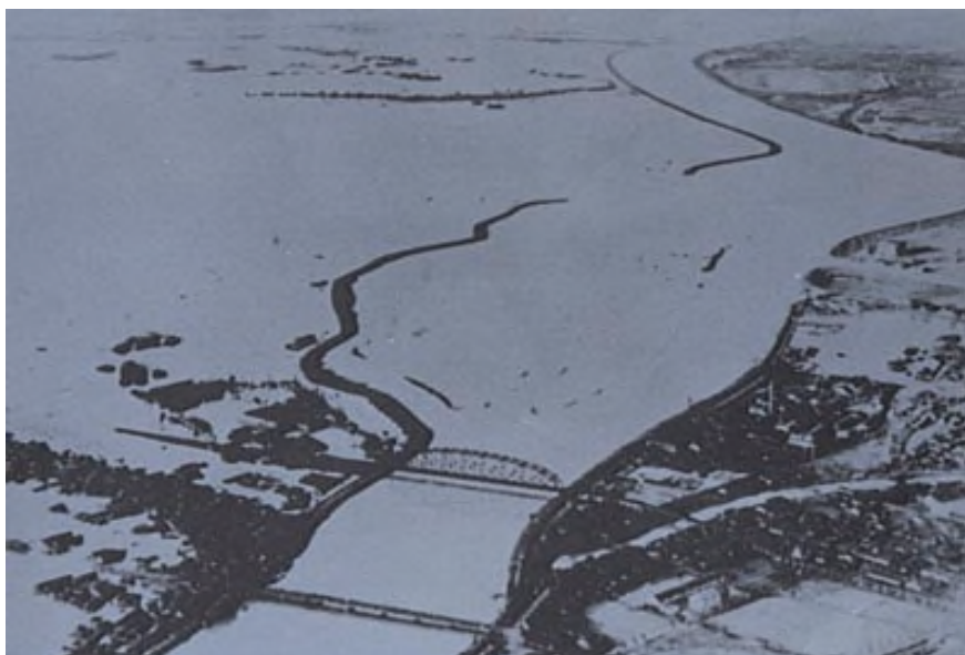
写真 1.1.3-1 久世郡久御山町での被害状況
