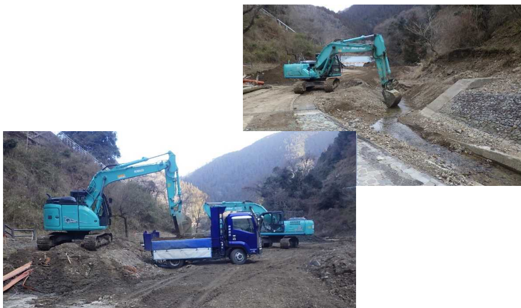
図 4.6-2 土砂撤去工事実施状況（令和 2 年度）
