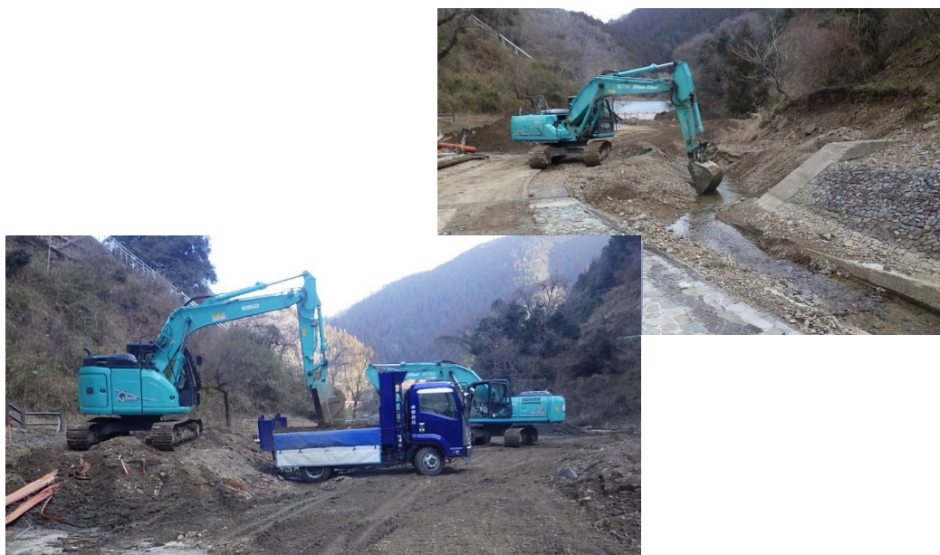
図 4.6-2 土砂撤去工事実施状況（令和 2 年度）
