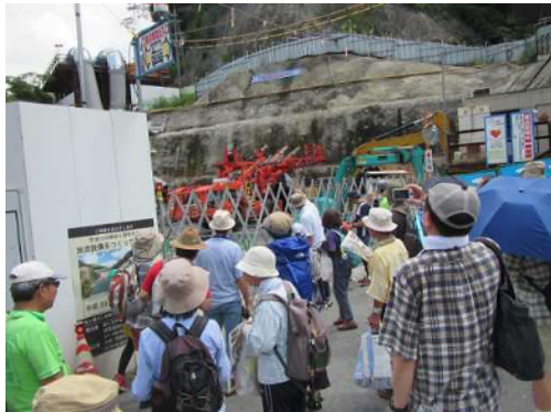
再開発事業工事現場の様子
