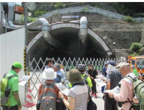
再開発事業工事現場の様子
