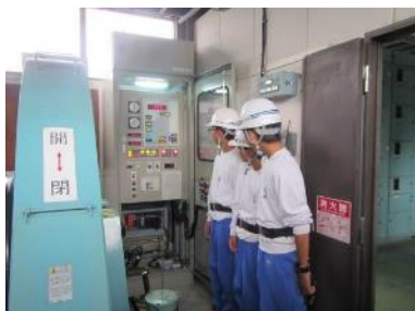
ダム本体の点検
