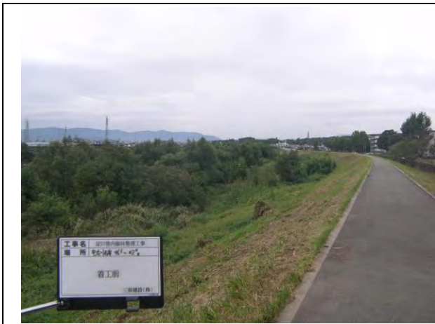
宇治川右岸 46.6~47.0k 着工前
