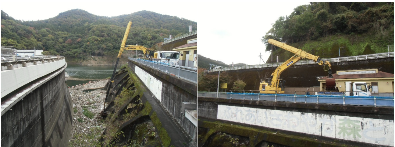
図 2.4-5 流芥の改修状況 (左)、陸上げ作業 (右)
