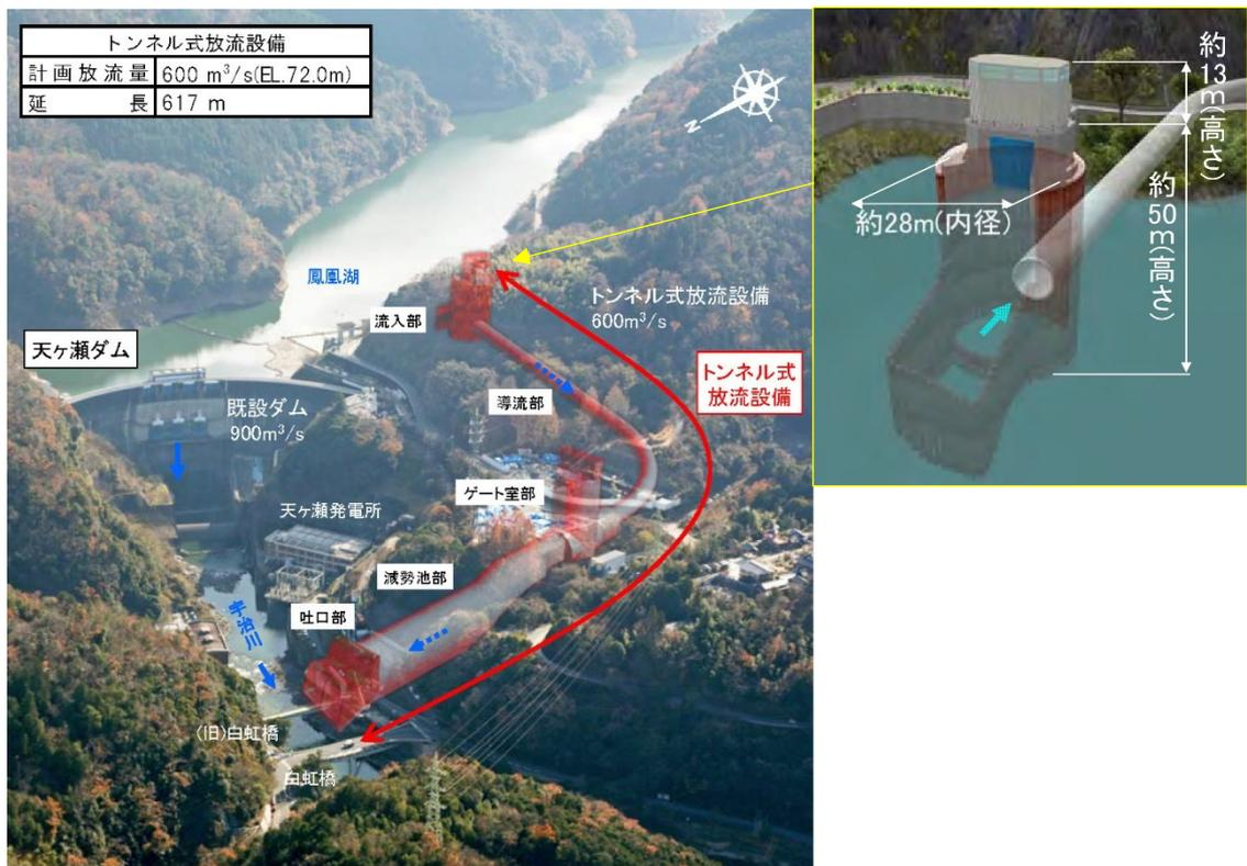
図 1.6-1 天ヶ瀬ダム再開発事業・トンネル式放流設備
