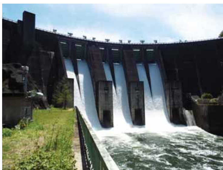
図 6.5.2-10 高山ダムフラッシュ放流状況 (最大放流量時)
