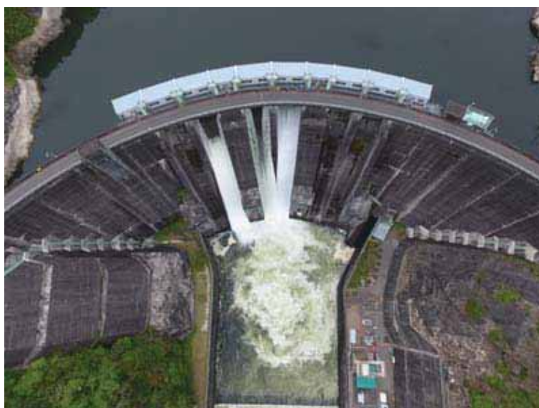
図 6.5.2-5 高山ダムフラッシュ放流状況（最大放流量時）
