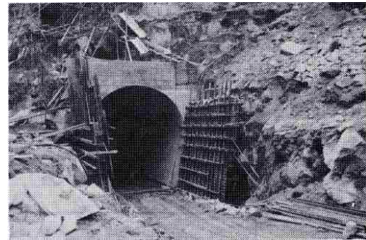
仮排水トンネル工事
