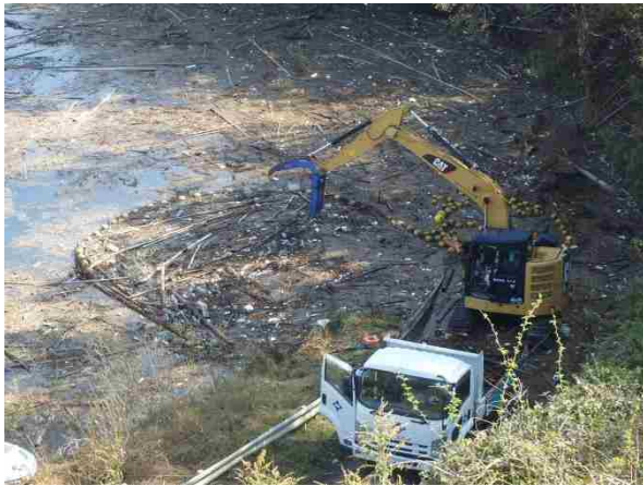
流木等の回収作業
