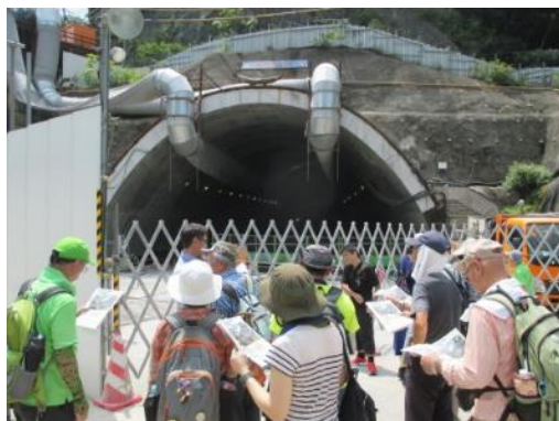
再開発事業工事現場の様子
