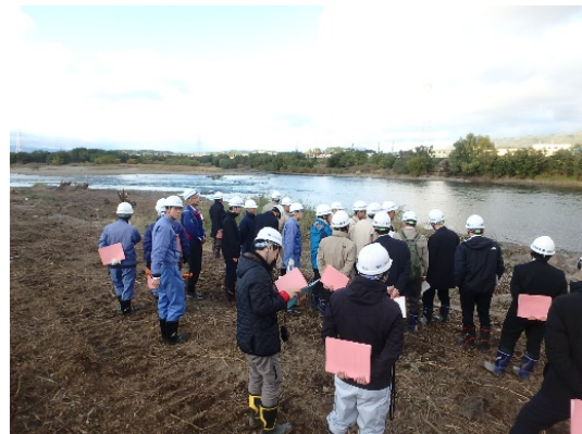
R1.11.20 現地調査 (置砂材料及び置砂設置場所の確認)
