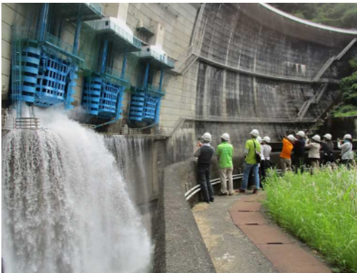
天ヶ瀬ダム見学の様子（ゲート点検）
