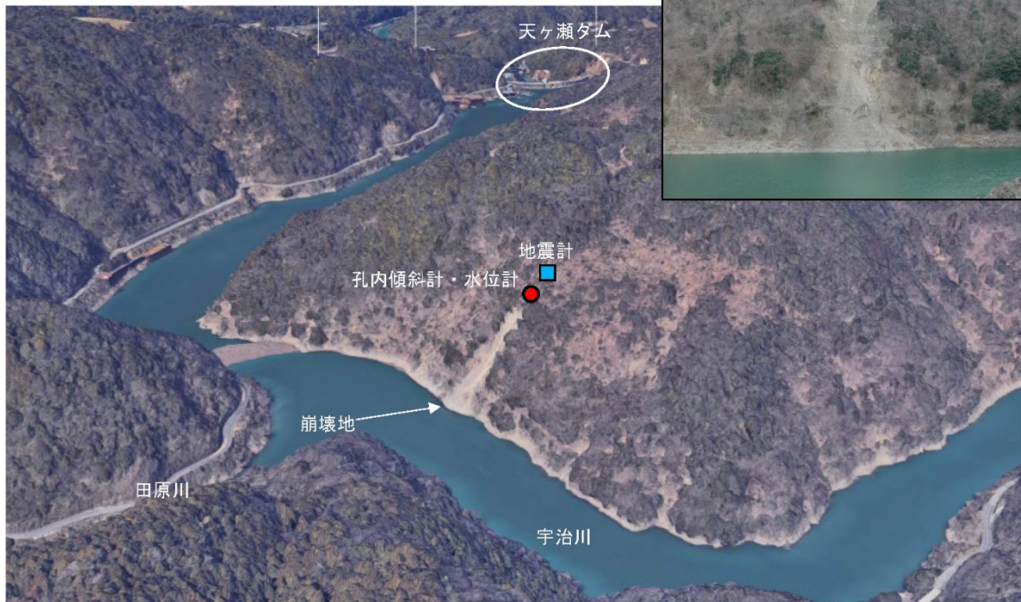
図 4.3-3 法面崩落個所でのモニタリングの状況
