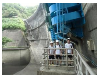
ダム本体の点検
