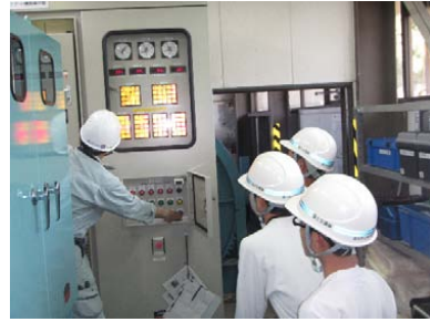
機械点検の様子
