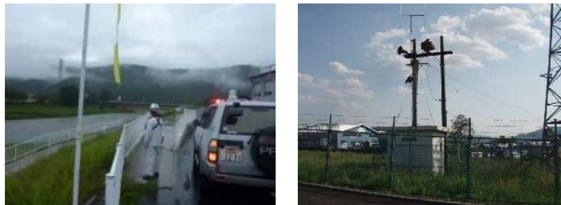
図 2.3.1-15 左：河川巡視の状況、右：警報局(サイレン及びスピーカ)
