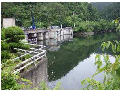
写真1 ダムサイト付近
