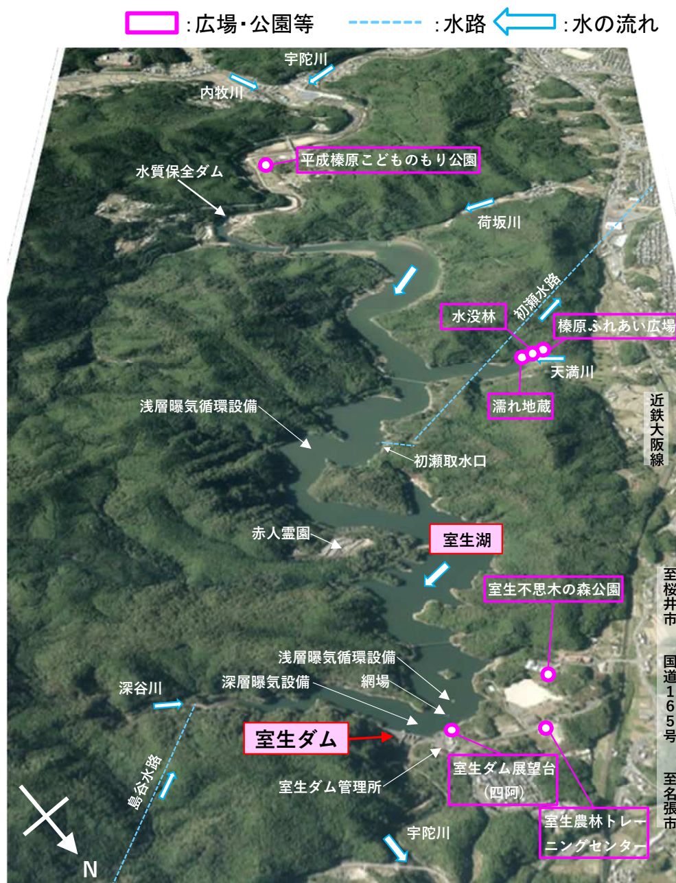
図 1.1-2 室生ダムとその周辺の状況
