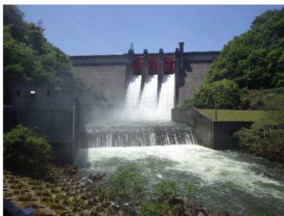
図 6.5.1-14 室生ダム放流状況
