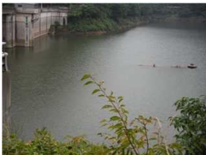
写真1 ダムサイト付近
