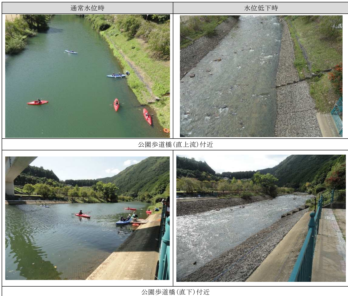
図 5.6.4-48 水質保全ダムの水位保持とラバーゲート倒伏後の水位低下の状況比較
