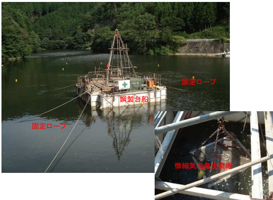
図 5.6.4-50 曝気設備(微細気泡発生装置、水質保全ダム直上に設置)
