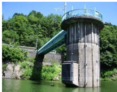
図 3.2.5-2 初瀬取水塔全景
