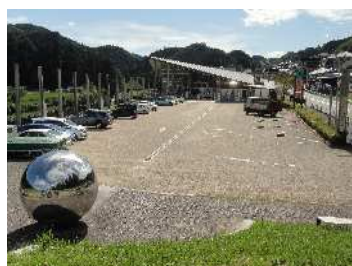
道の駅 宇陀路室生
