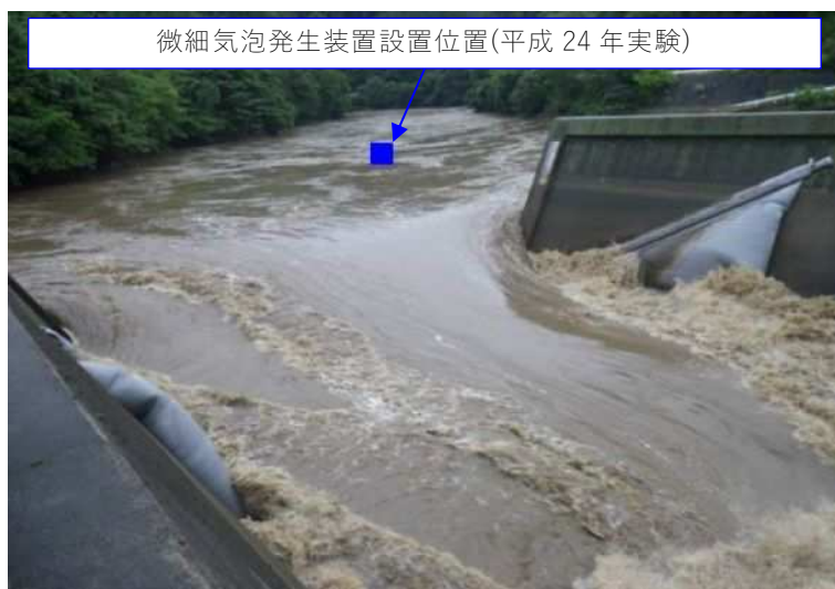
図 5.6.4-53 水質保全ダムのラバーゲート倒伏完了時点の状況 (流入量 150m 3 /s で自動倒伏)
