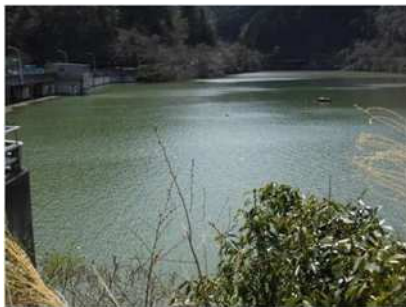
写真1 ダムサイト付近
