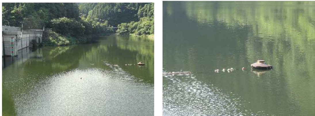
図 5.6.1-8 深層曝気設備
