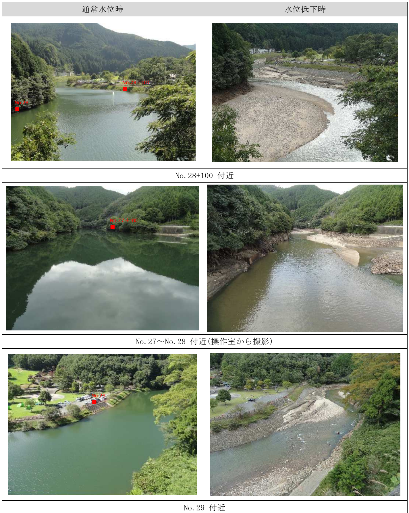
図 5.6.4-47 水質保全ダムの水位保持とラバーゲート倒伏後の水位低下の状況比較
