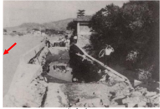
県道海南九度山線：麻生津 おうつ ～竜門間の被害状況 (昭和 28 年台風 13 号)
