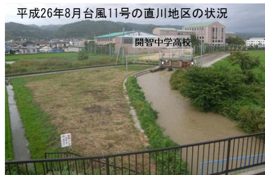
図 2.5-2 大堰建設後の洪水時の状況
