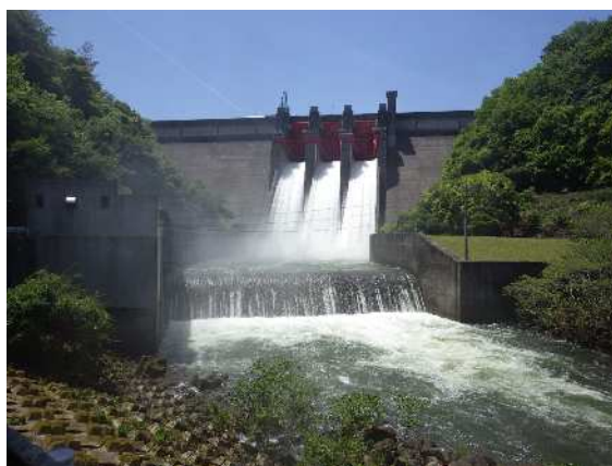
図 6.5.1-14 室生ダム放流状況
