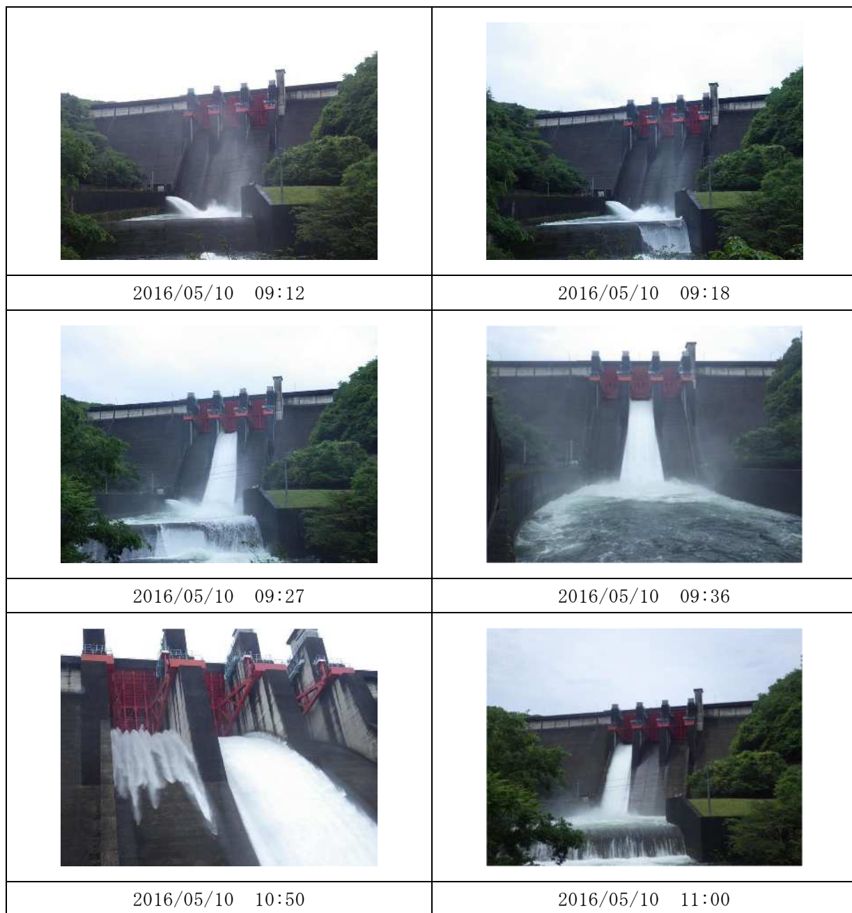
図 6.5.1-12 室生ダム放流状況
