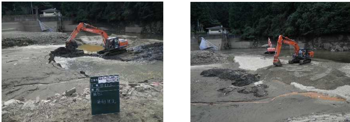
図 5.6.4-42 水質保全ダム堆砂除去工事の状況
