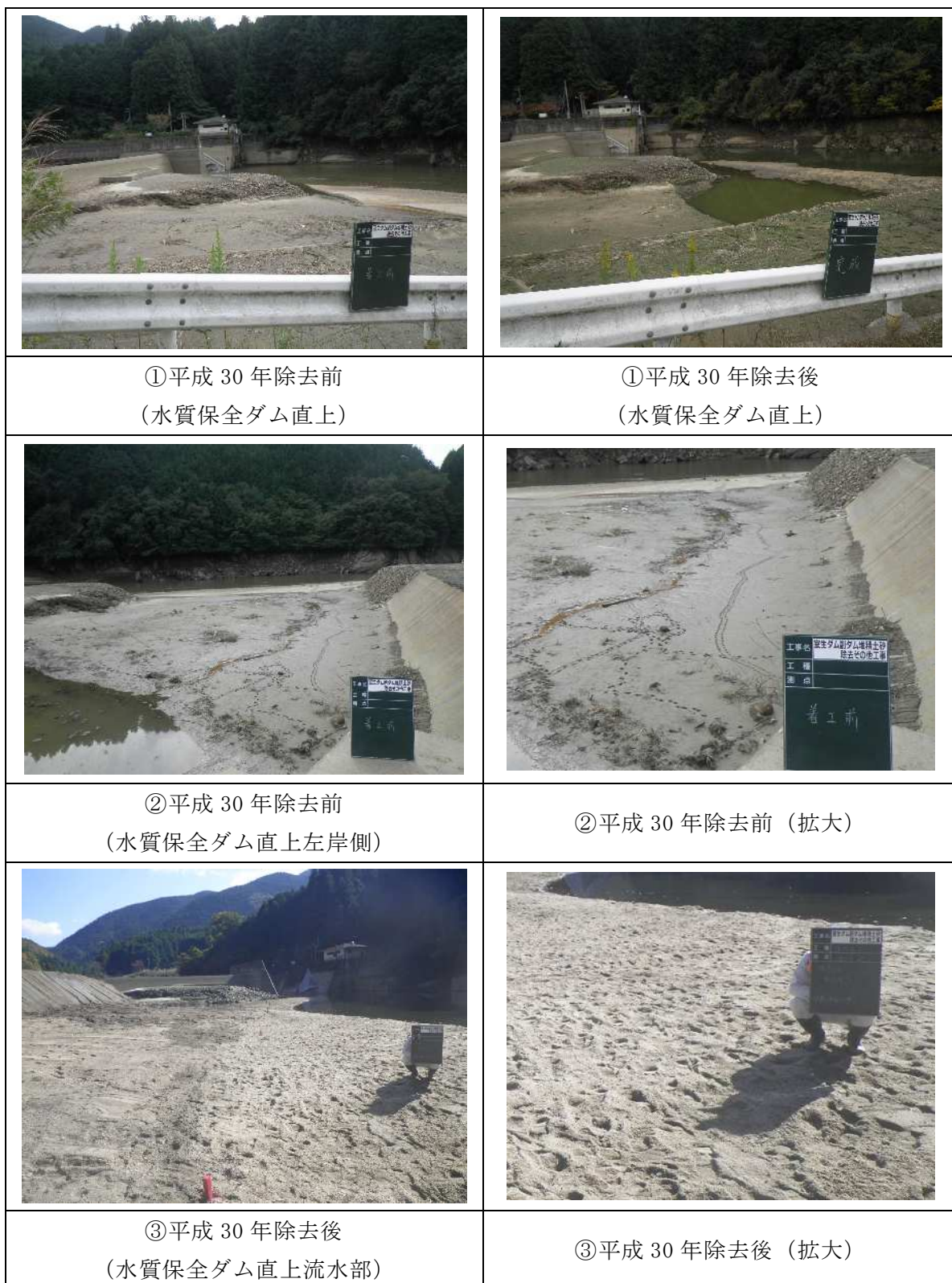
図 5.6.4-10 平成 30 年水質保全ダム堆砂除去の様子
