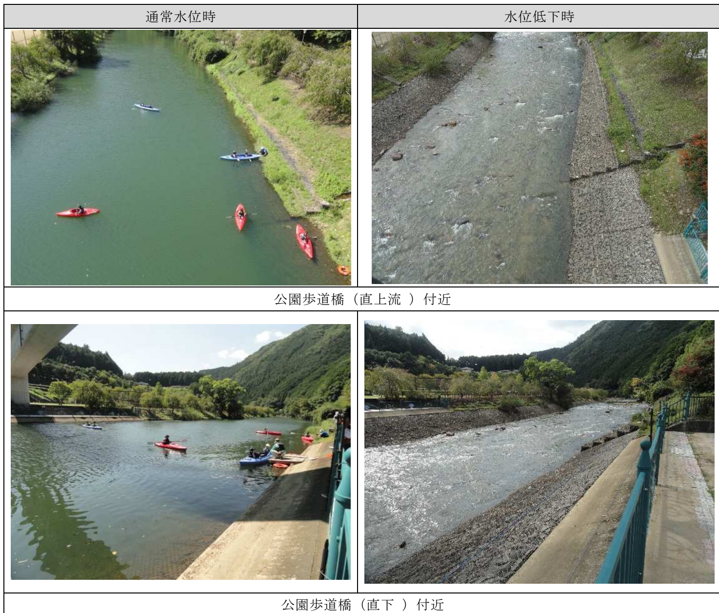
図 5.6.4-45 水質保全ダムの水位保持とラバーゲート倒伏後の水位低下の状況比較
