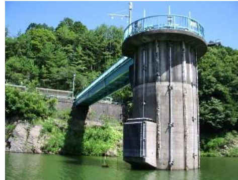
図 3.2.5-2 初瀬取水塔全景
