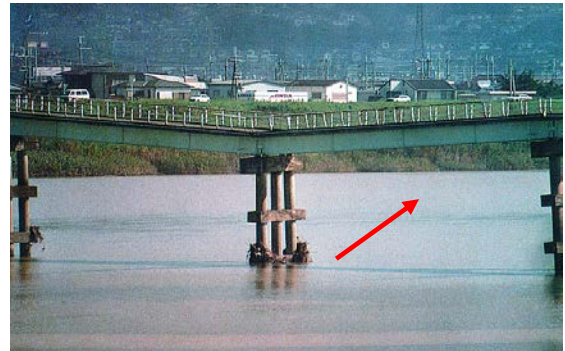
川底がえぐり取られて陥没した南海橋 (平成 2 年台風 19 号)
