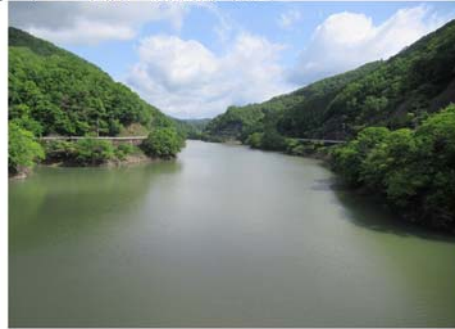
① りんどう橋上流側貯水池
