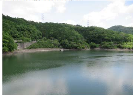
⑥ 出合地区護岸付近貯水池
