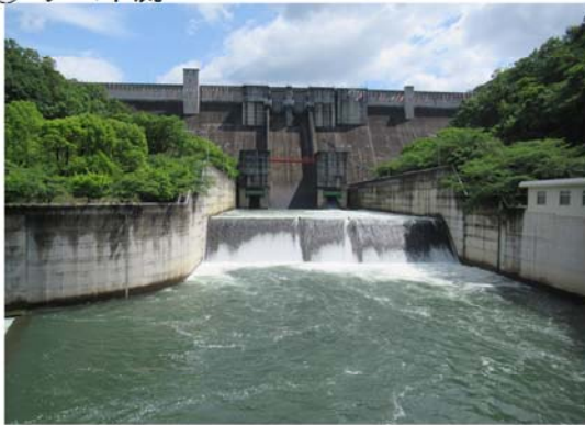
⑨ ダム下流
