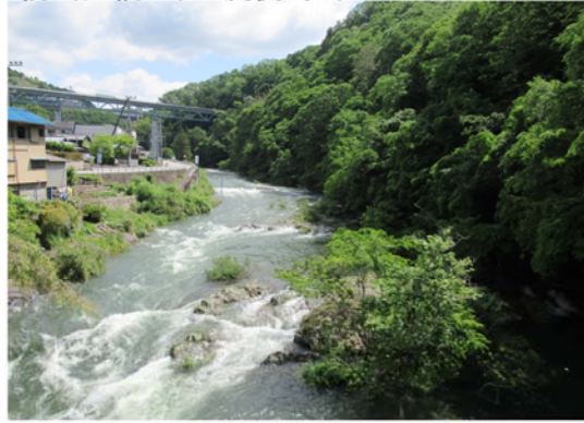
⑧ 前川大橋より上流側河川
