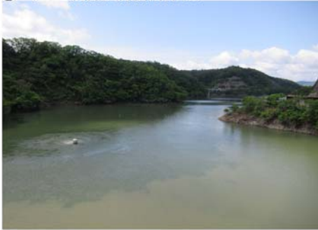
① りんどう橋下流側貯水池
