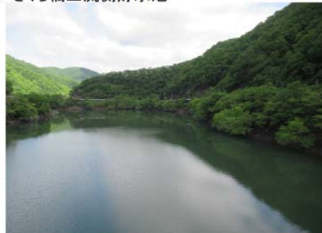
④ さくら橋上流側貯水池
