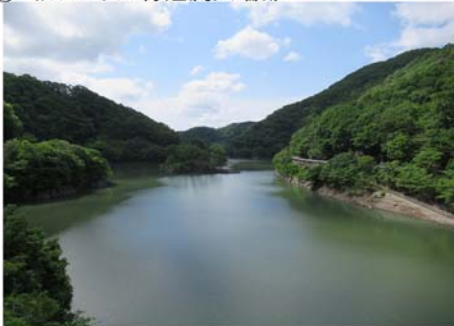
⑤ 旧トンネル付近流入端部
