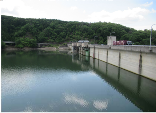
⑦ ダムサイト選択取水設備付近
