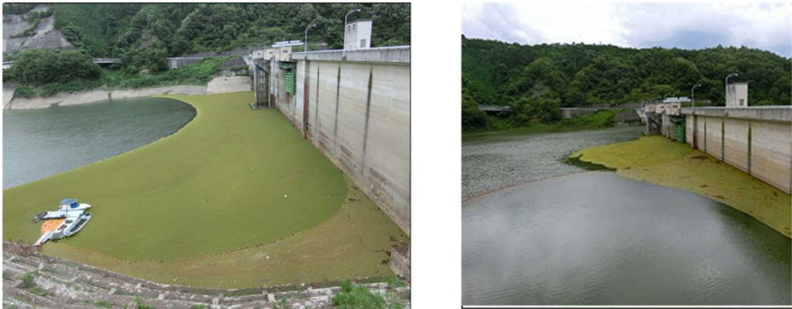
図 1.1-18(2) 一庫ダムの湧水状況(平成 26 年度)
