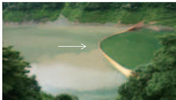
図 5.6-3 濁水防止フェンス(洪水後、沈操作前)
