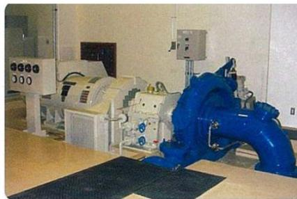
写真3.4-1 ダム管理用発電施設 (MWh/年)
