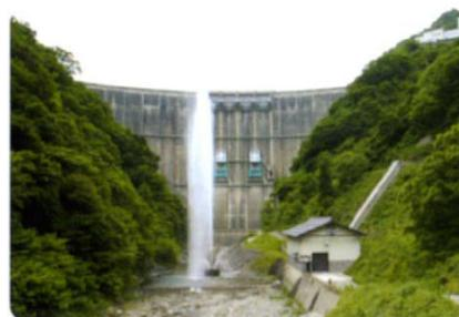
写真3.4-2 噴水によるダム直下放流の様子
