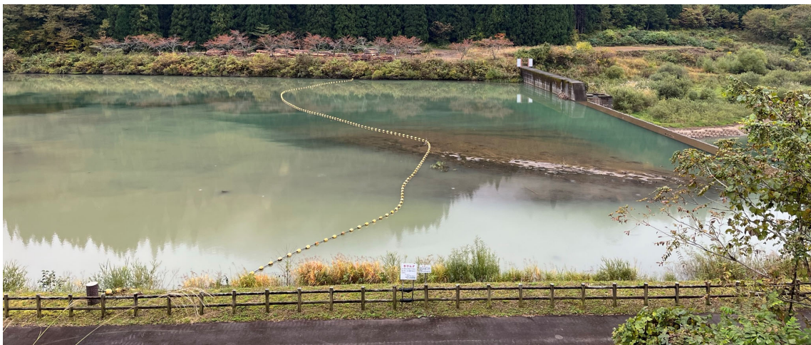
写真 4.5-1 副ダム湛水池の状況 (令和5年10月撮影)
