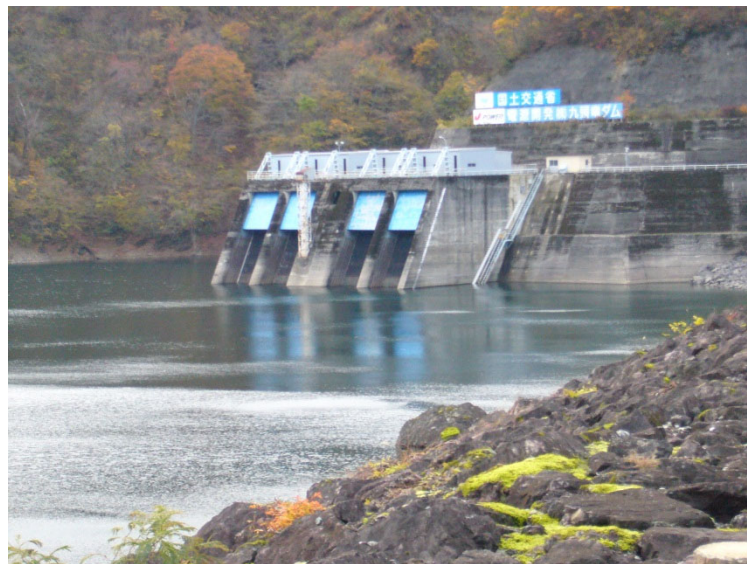
写真 3.2-2 九頭竜ダム発電取水部
