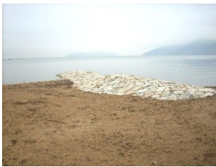
e) 2号突堤の本設状況
