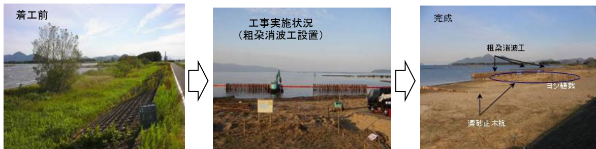
粗朶消波工とヨシの植栽により地盤の安定化を行う (2007年(平成19年)12月時点)
