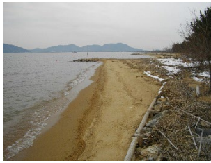
g) 1号突堤の本設状況
