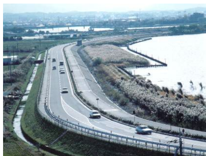
湖岸堤と前浜（植栽されたヨシ帯）
