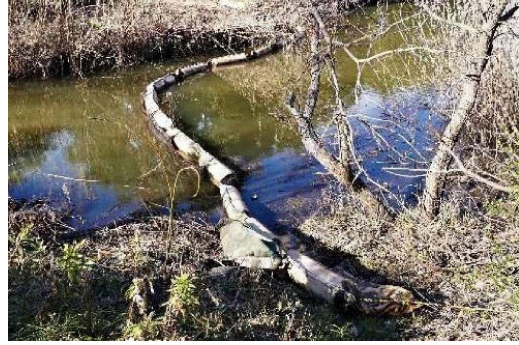
侵入防止施設の設置
