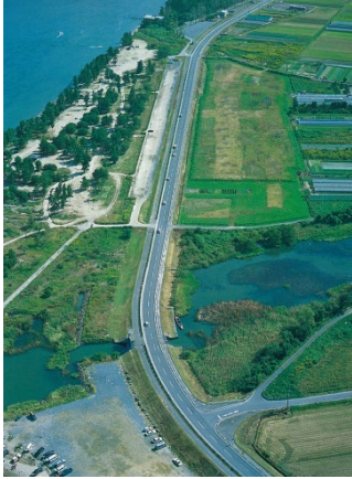
1) 湖岸堤・管理用道路の建設
