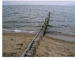
c) 3号突堤の状況
