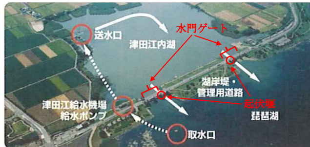
写真 1.3-2 津田江内湖の水位保持施設
