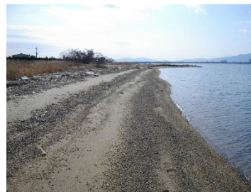
b) 2号突堤より北側の状況
