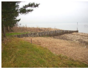
d) 1号突堤の改良状況
