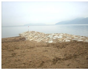
f) 3号突堤の本設状況
