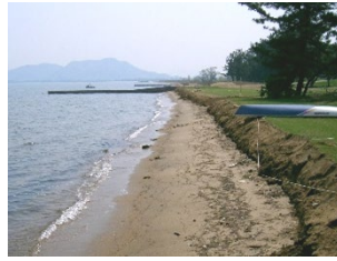
b) 2号突堤より西側の状況
