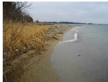
e) 5号突堤より北側の状況
