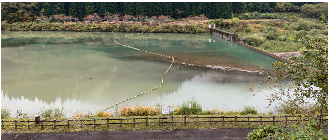
写真 4.5-1 副ダム湛水池の状況 (令和5年10月撮影)
