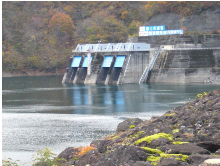
写真 3.2-2 九頭竜ダム発電取水部
