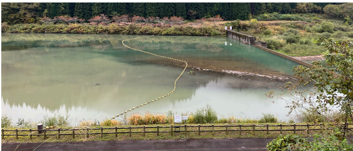
写真 4.5-1 副ダム湛水池の状況 (令和5年10月撮影)
