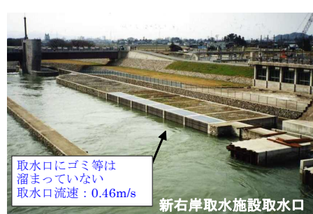
図 3.3-9 鳴鹿大堰及び鳴鹿堰堤の右岸取水施設
