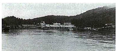
坂井郡金津町管野水口付近
