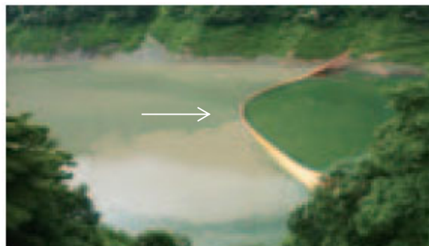
図 5.6-3 濁水防止フェンス(洪水後、沈操作前)
