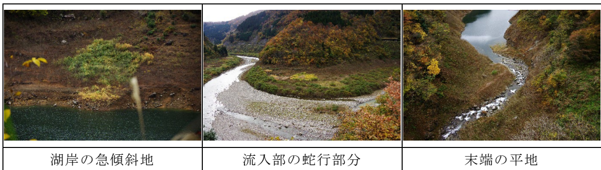
写真 6.3-2 水位変動域の状況
