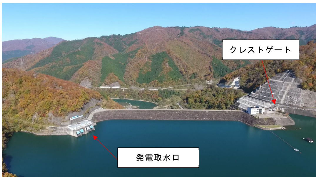
図 1.2-8 九頭竜ダム取水・放流設備
