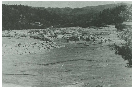
写真 1.1.3-1 木津川下流部の被害状況(三重県阿山郡付近)
